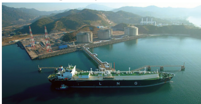
Dapeng Guangdong regas terminal
