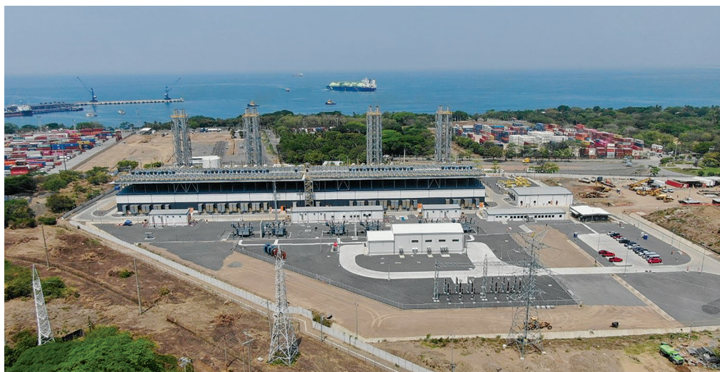
Energía del Pacífico LNG-to-power plant
