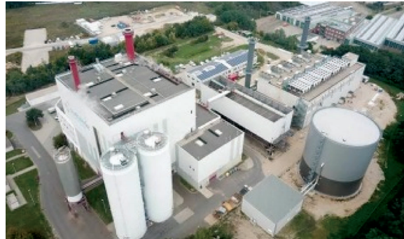
New municipal CHP in Frankfurt (Oder)
