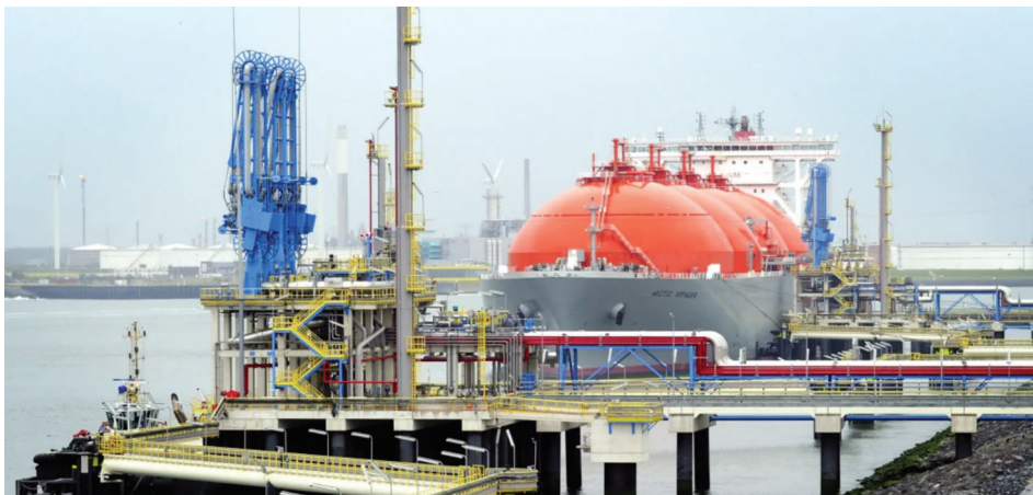
Tanker discharging at GATE LNG terminal
