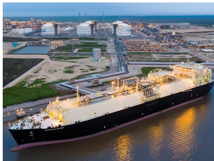
Cheniere's Sabine Pass LNG terminal
