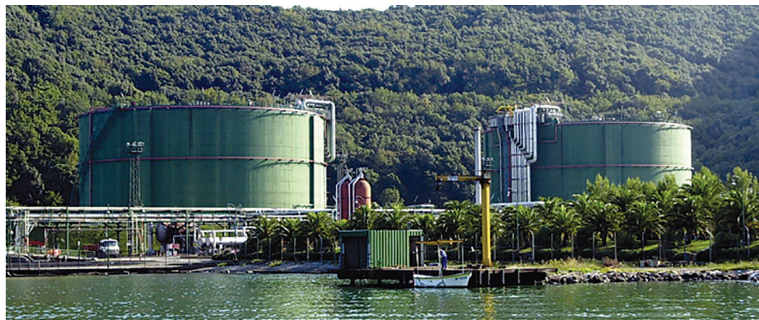
La Spezia's Panigaglia LNG terminal
