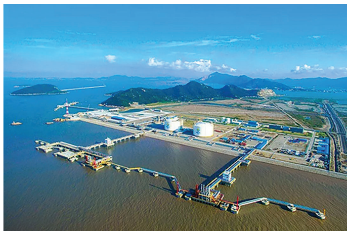
ENN's Zhoushan LNG terminal in China
