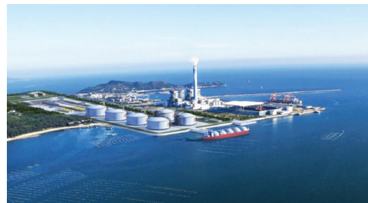
View of Huizhou LNG terminal
