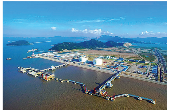
View of ENN’s Zhoushan LNG terminal
