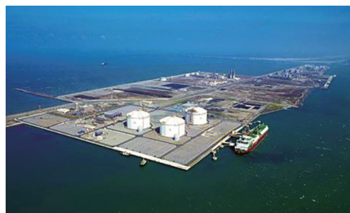
Bird's eyes view of Taiwanese LNG import terminal
