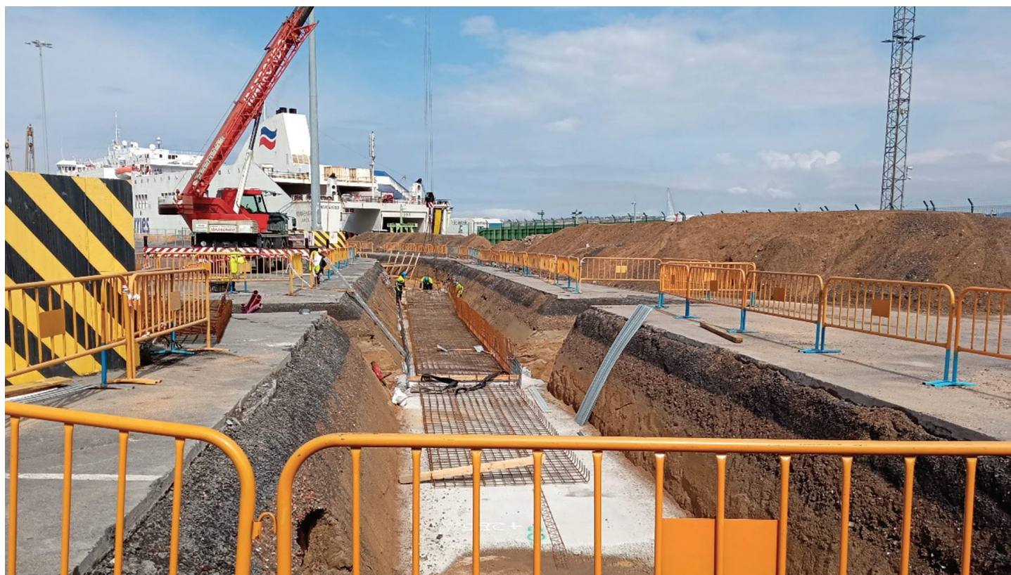
Construction at Bilbao LNG bunker terminal
