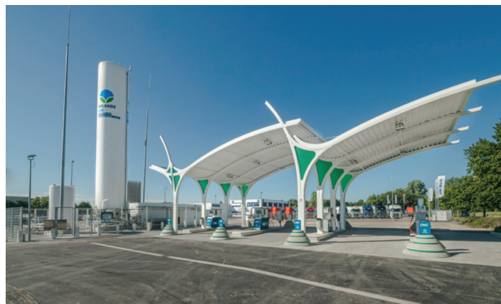
Rolande LNG fuelling station
