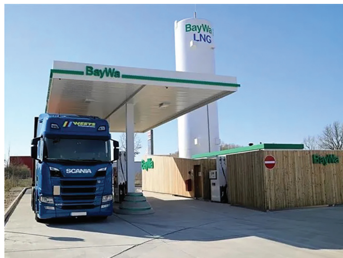
BayWa LNG station
