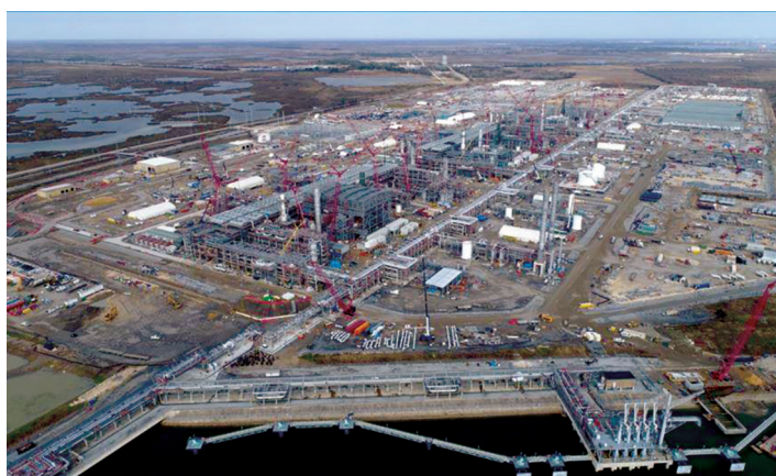
Construction of Cameron LNG Train1-3
