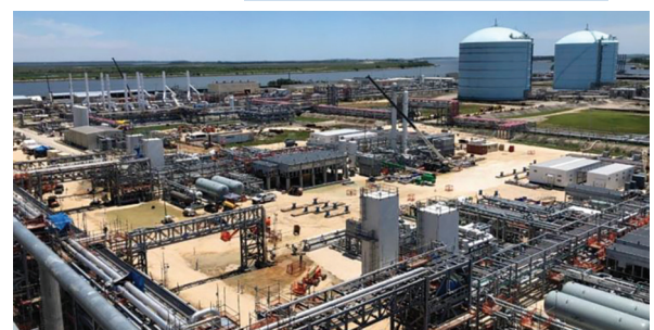
Conversion of Elba Island LNG
