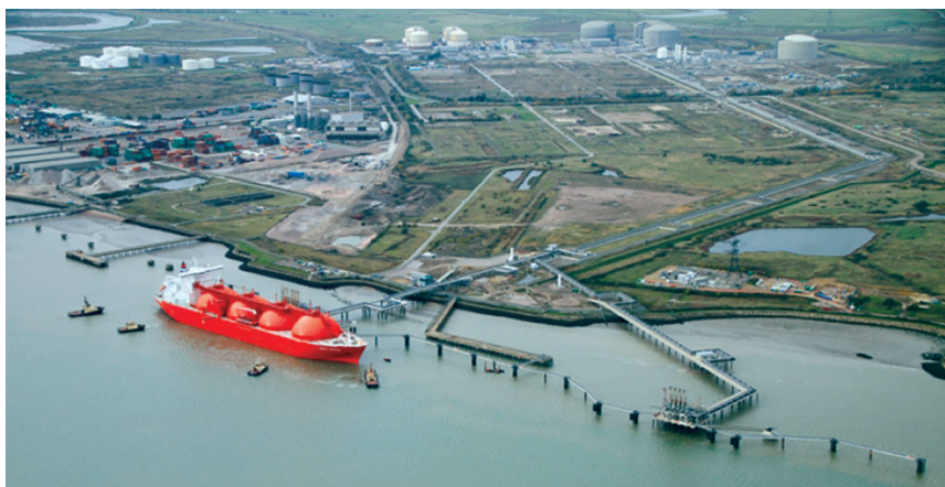
Grain LNG terminal in Kent
