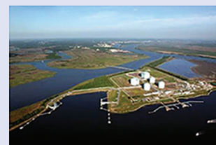
The Elba LNG project moves a step closer
