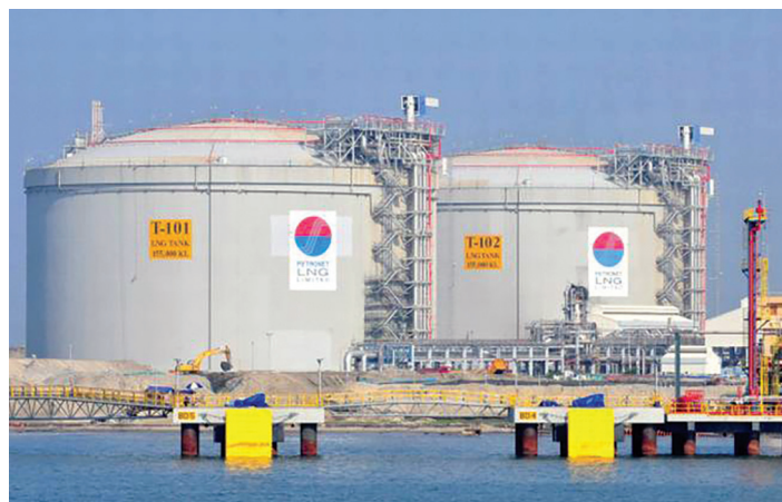
Petronet LNG storage hub
