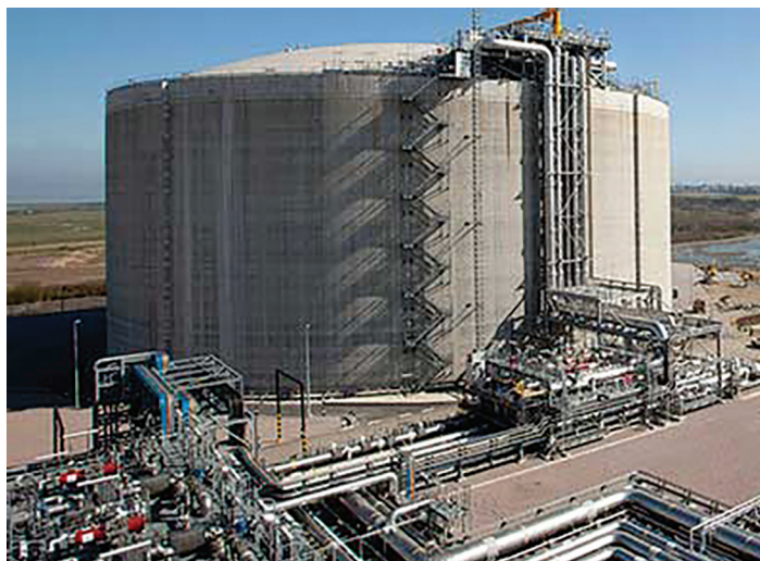
LNG storage tank on the Isle of Grain
