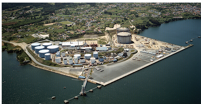
The Mugardos LNG terminal
