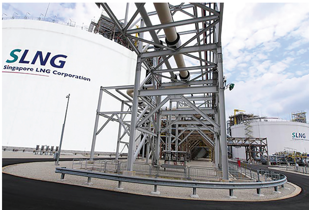
Singapore LNG Corporation facility
