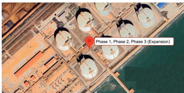
PetroChina's Tangshan LNG terminal
