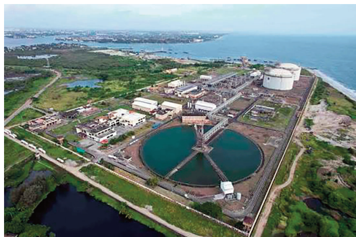
Petronet's Kochi LNG terminal
