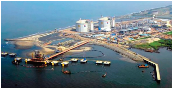
Chhara LNG terminal in India
