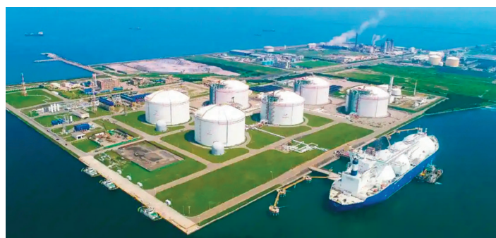
Petronet's Dahej LNG terminal
