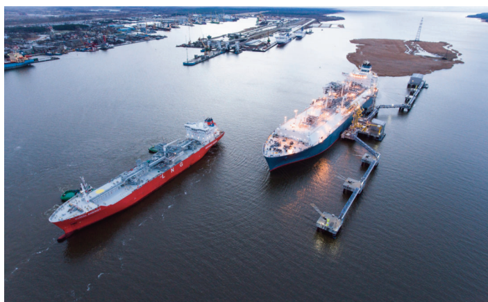
Klaipėda LNG terminal
