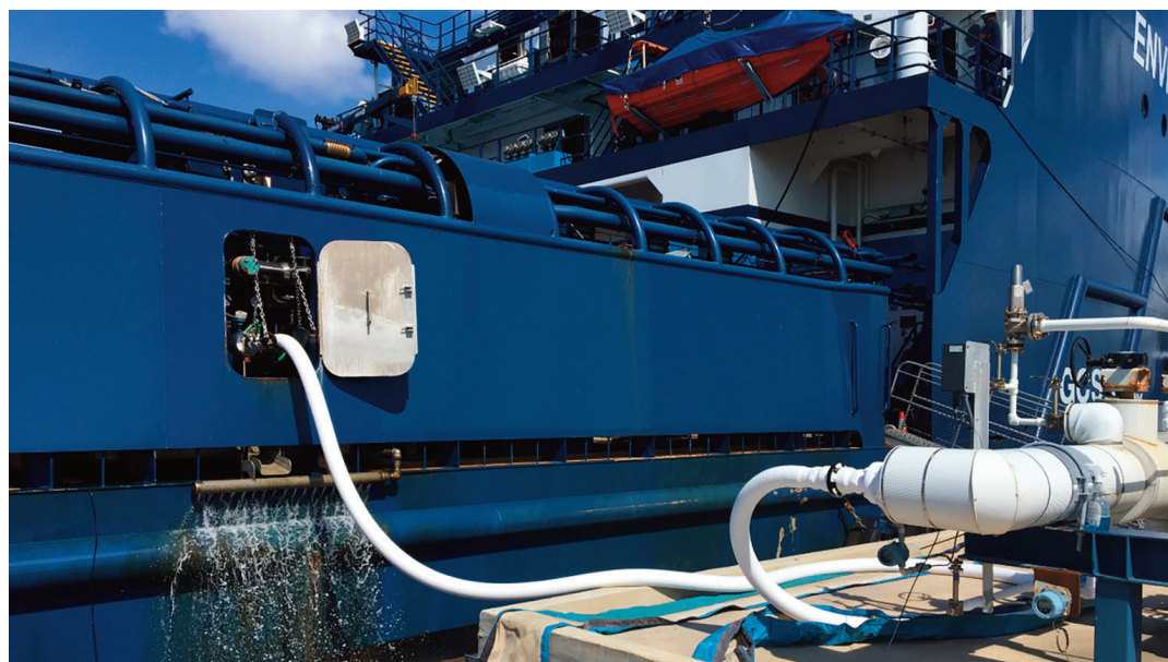
LNG bunkering in process
