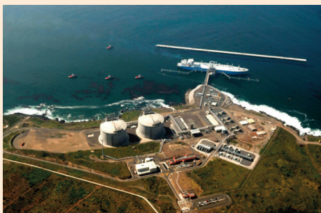
Pacific-facing ECA LNG in Baja California
