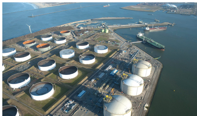
Gate LNG Terminal
