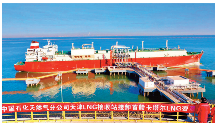
LNG tanker berthing at CNOOC's Tianjin regas terminal
