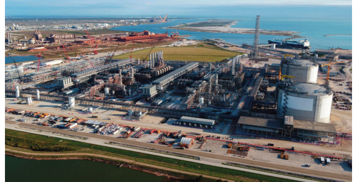
Cheniere's Corpus Christi LNG terminal
