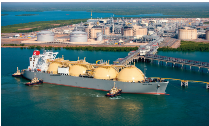
Ichthys LNG in northwest Australia
