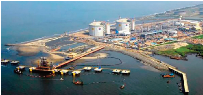
Chhara LNG terminal in India
