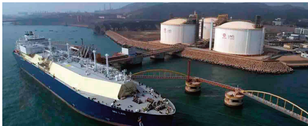
PetroChina loads cargo at Dalian LNG terminal
