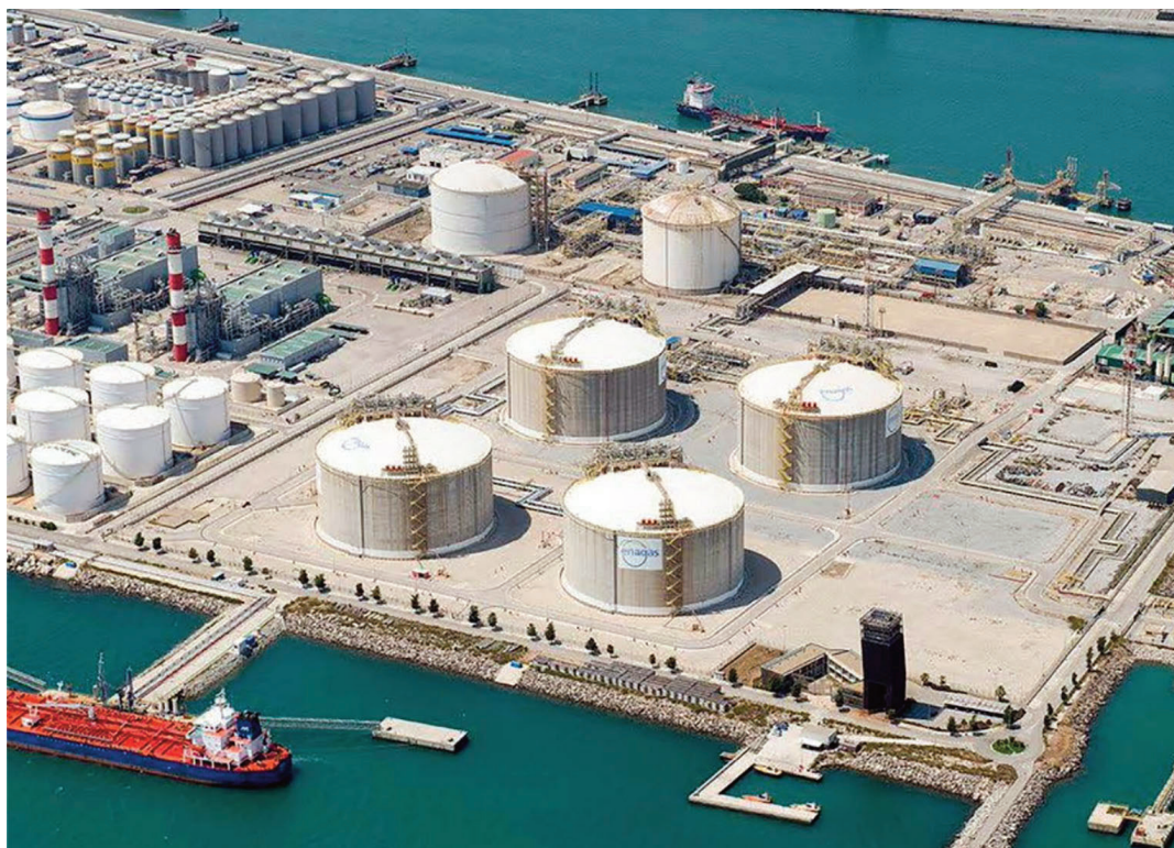
Barcelona LNG regasification terminal
