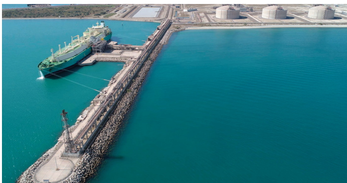
Fos Cavaou LNG Terminal
