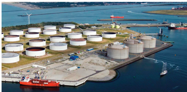
LNG storage at Port of Rotterdam
