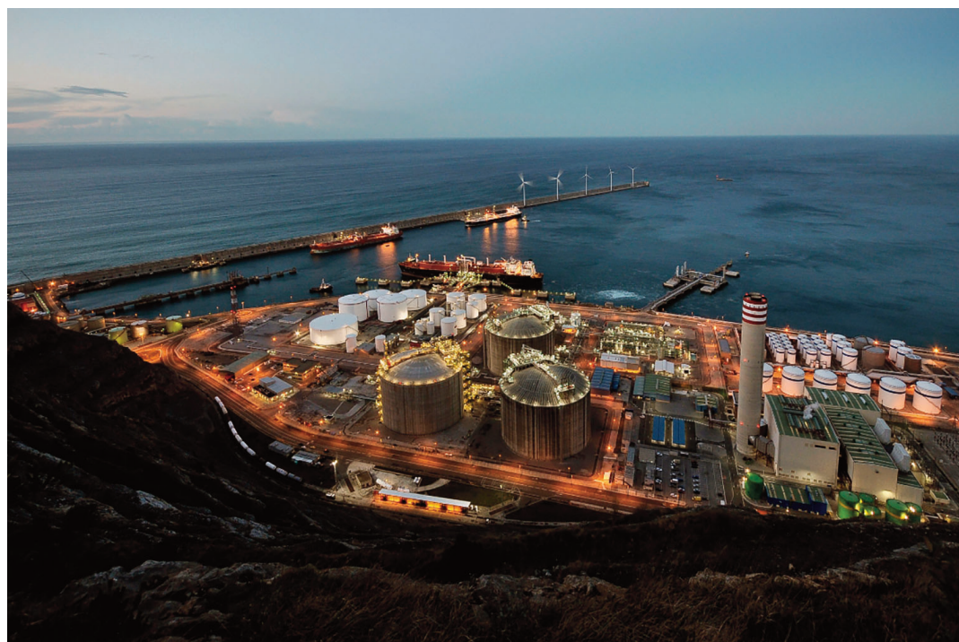
Bilbao LNG terminal
