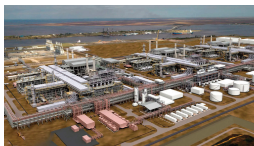
Golden Pass LNG terminal
