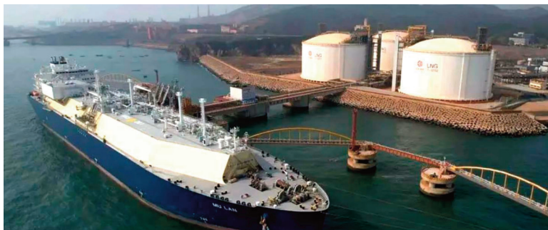
PetroChina loads cargo at Dalian LNG terminal
