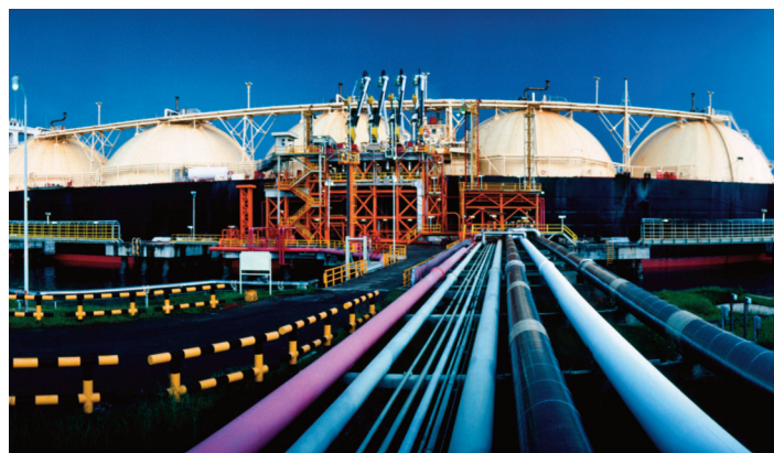
LNG export facility
