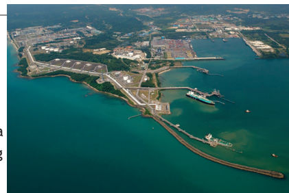
LNG Complex in Bintulu, Sarawak
