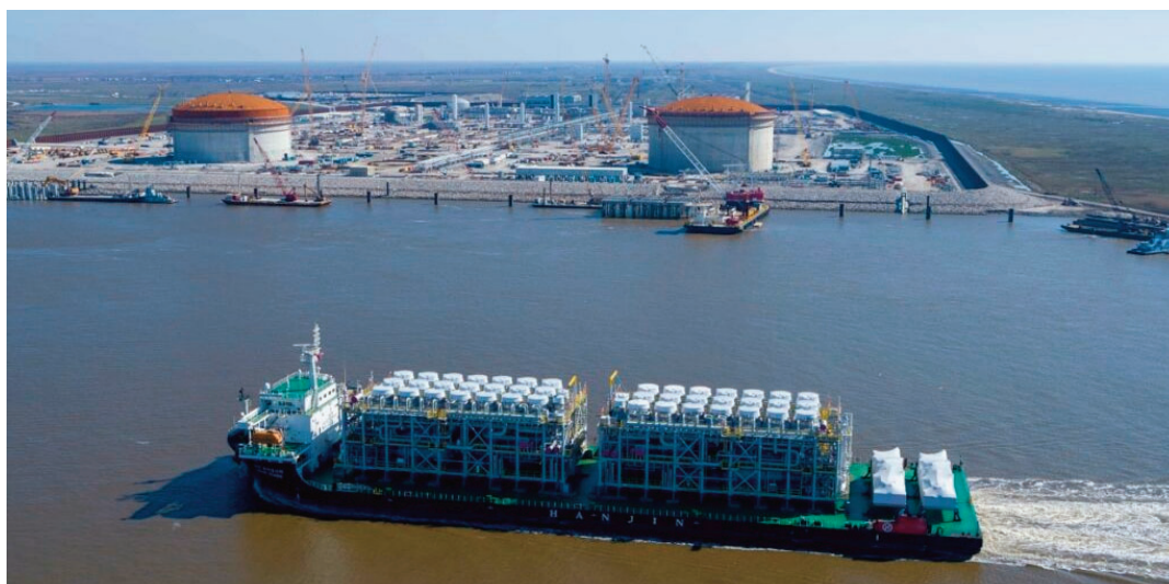
Illustration of CP2 LNG facility
