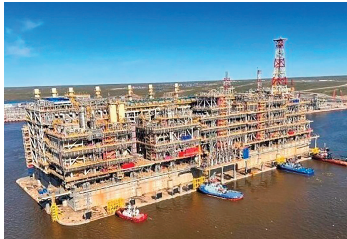
A major Arctic LNG 2 module arrives on site
