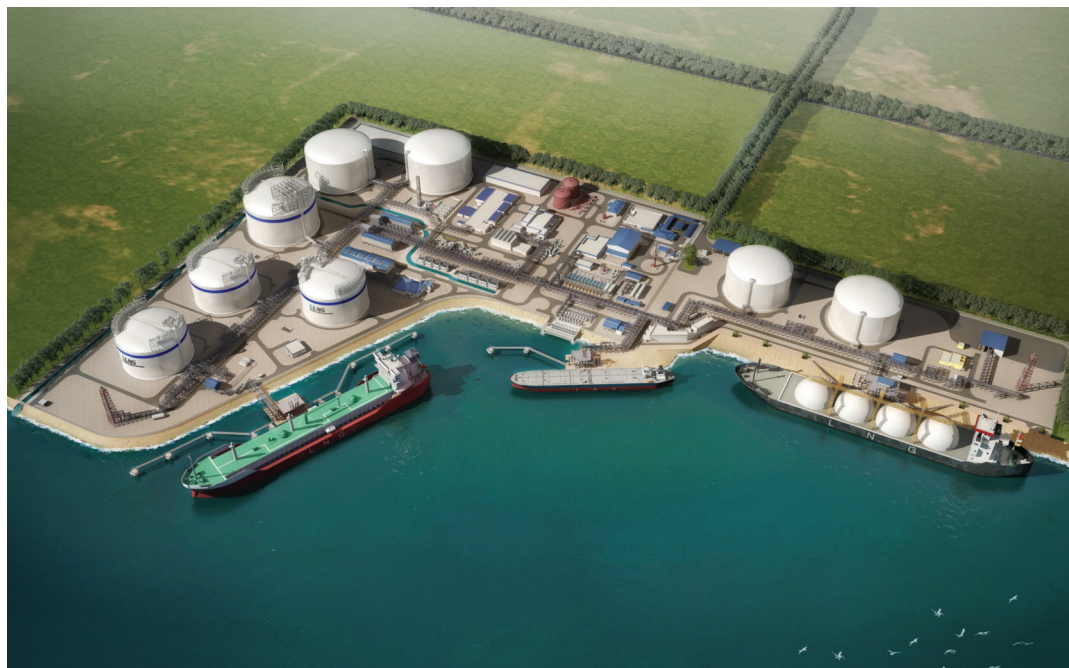
Singapore LNG terminal
