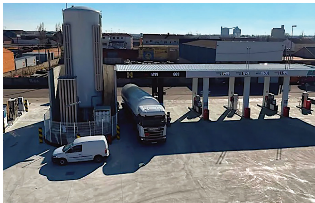
Zamora LNG / CNG refuelling station
