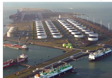
Rotterdam LNG terminal
