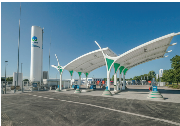
LNG fuelling station
