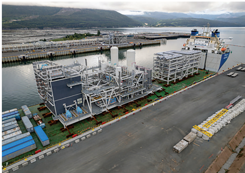
The last module arrives for the Canada LNG project
