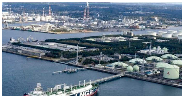
LNG carrier berthing at a Japanese port
