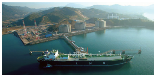
Guangdong Danpeng is China's first LNG import terminal
