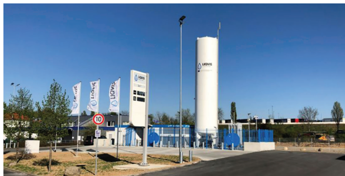
Liqvis LNG fuelling station
